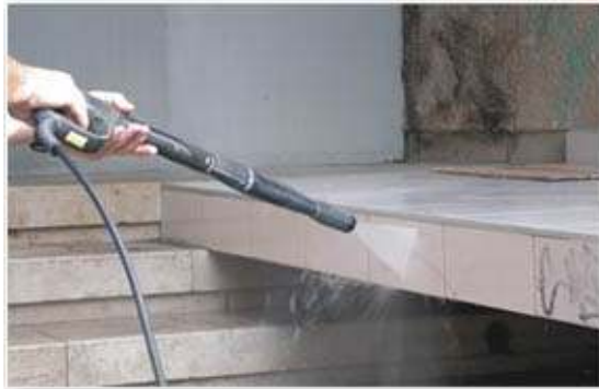
4. ábra Nanocolltech oldószerekkel kezelt járólap tisztítása magasnyomású mosóval
