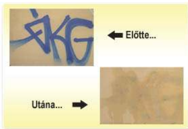
2. ábra Falfirka eltávolítása vakolt felületről Nanocoll SOFT (bal oldalon) és Nanocoll MILD (jobb oldalon) oldószerrel
