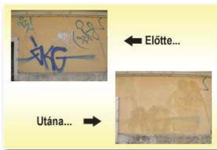
1. ábra Falfirka eltávolítása vakolt felületről
